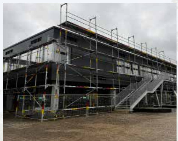
Komplett eingerüstet präsentiert sich derzeit das Berufliche Schulzentrum Schwäbisch Gmünd.
